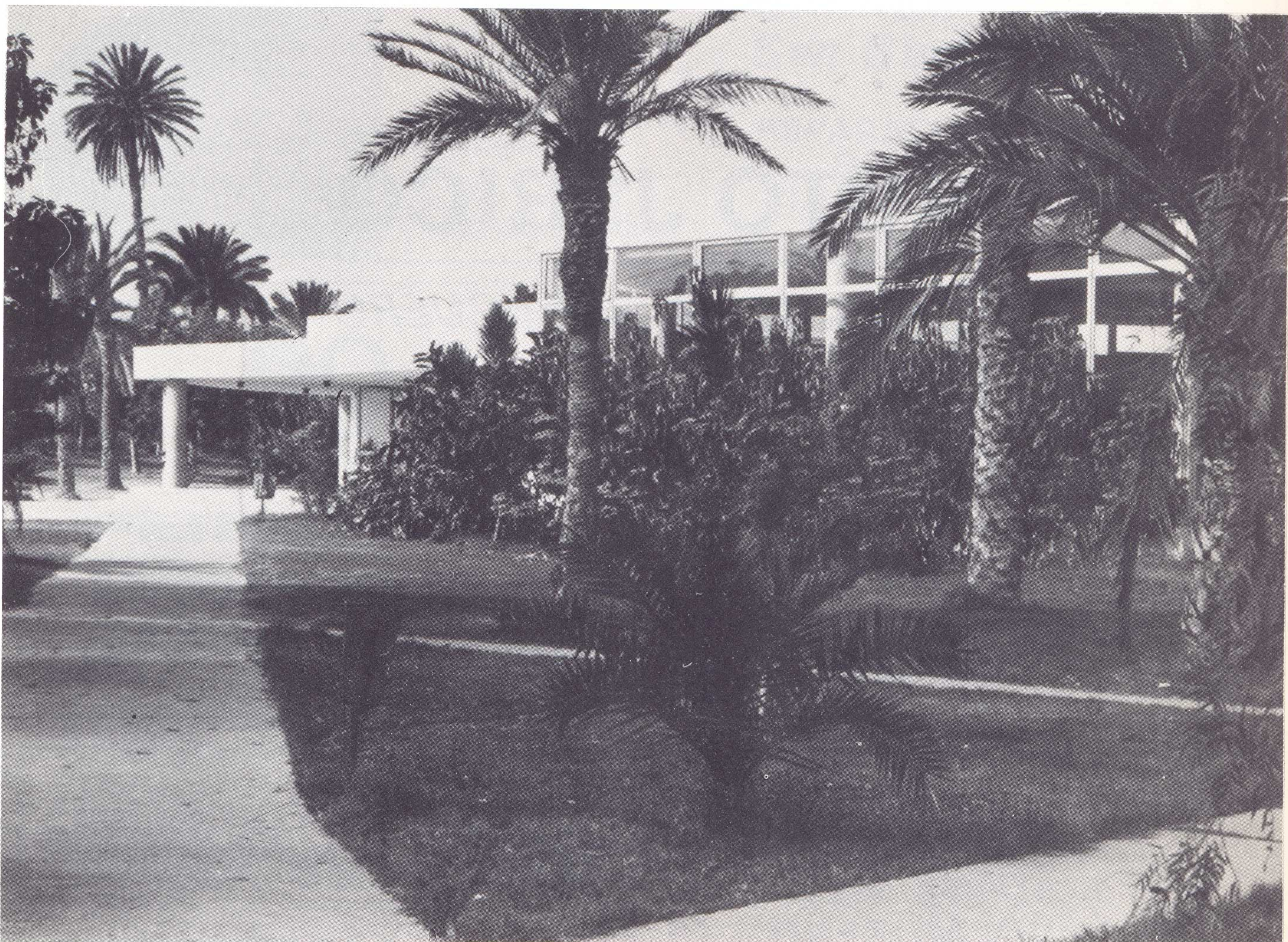
CEI de LAS PALMAS: 248.000 metros cuadrados, de los que 20.000 corresponden a edificaciones. Hermosas zonas ajardinadas, palmeras, arbustos tropicales y extensos macizos de césped que, con las numerosas instalaciones deportivas, forman un conjunto admirable.
