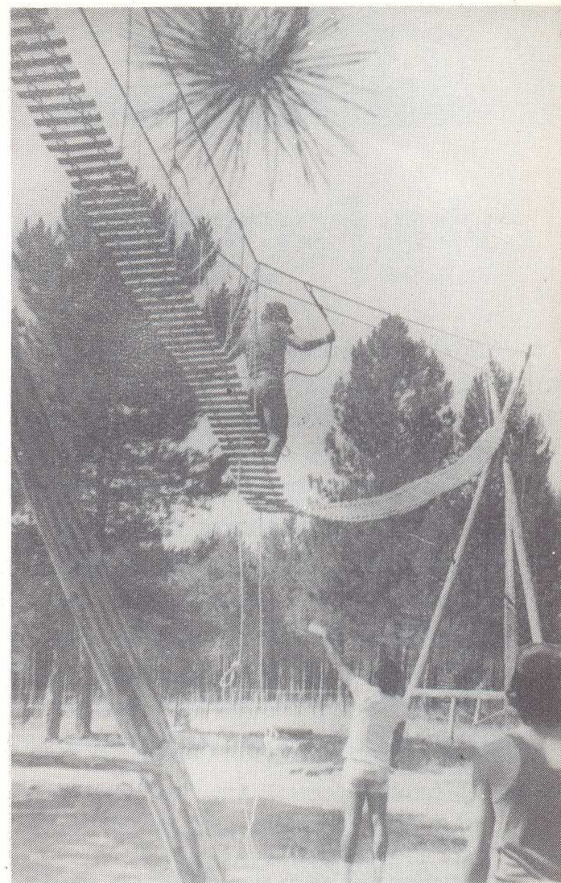
Pasarela en construcción.
