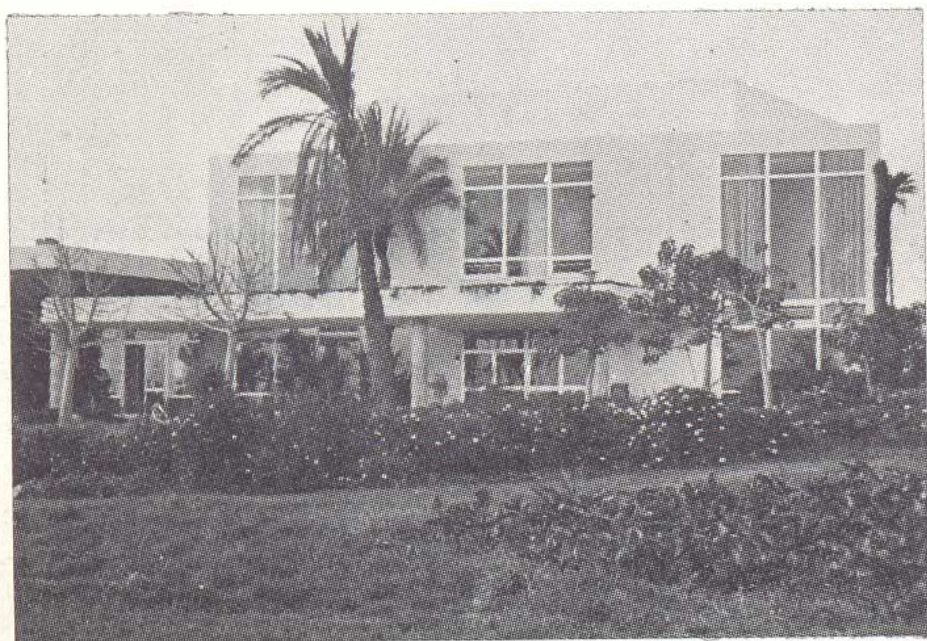
Detalle de las edificaciones
