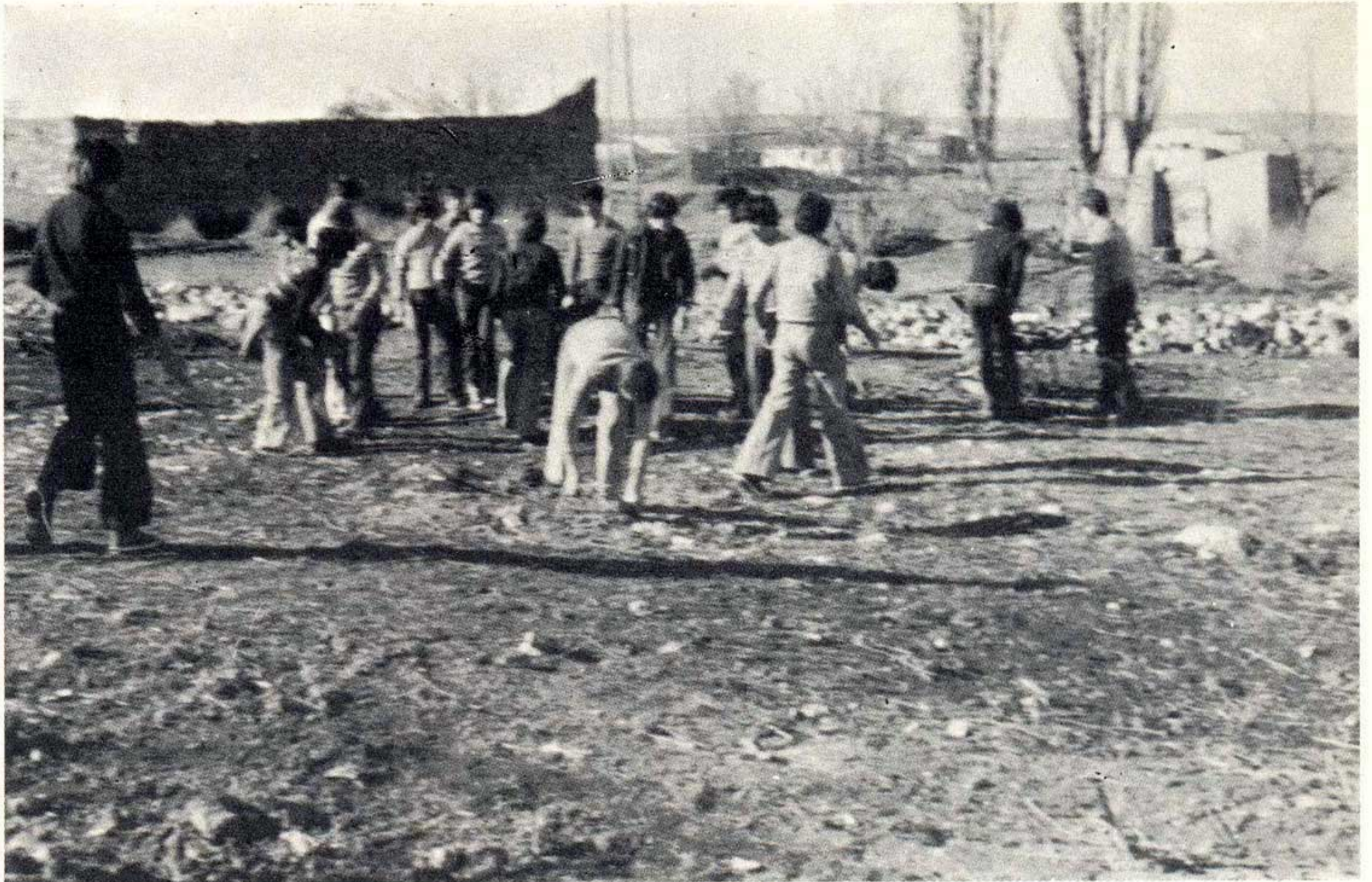
Otros trabajos en Villar de Chinchilla.
